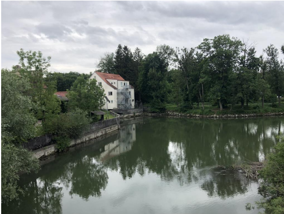
Abbildung 6: Blick von der Lände Richtung Aumühle, in Fließrichtung rechtes Ufer Obermühlenkanal, Foto WP vom 22.06.2022
